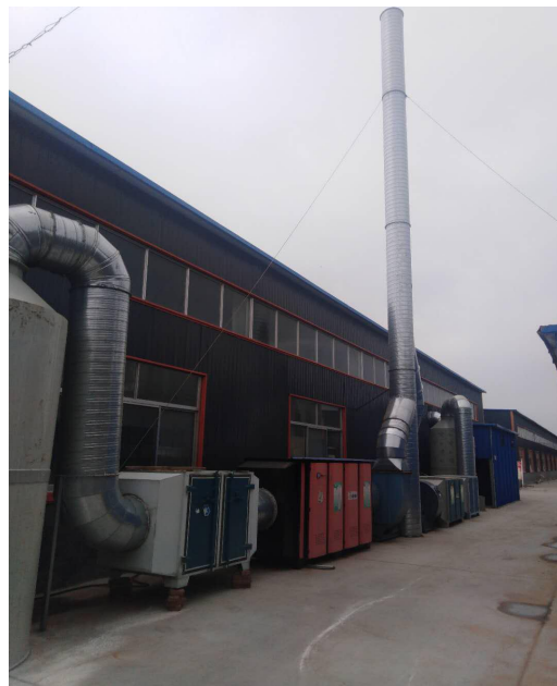
喷漆废气设置 UV 光催化氧化装置+排气筒
