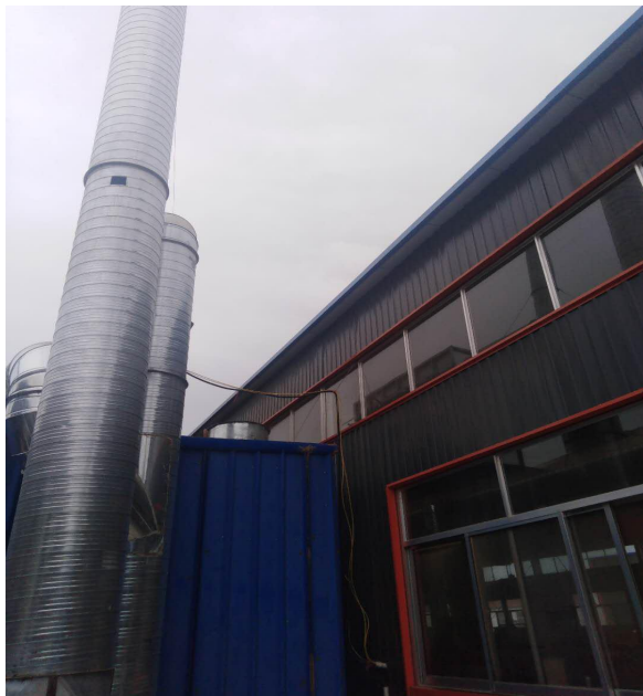
开料、机加工、砂光、打磨工序设置布袋除尘器+排气筒
